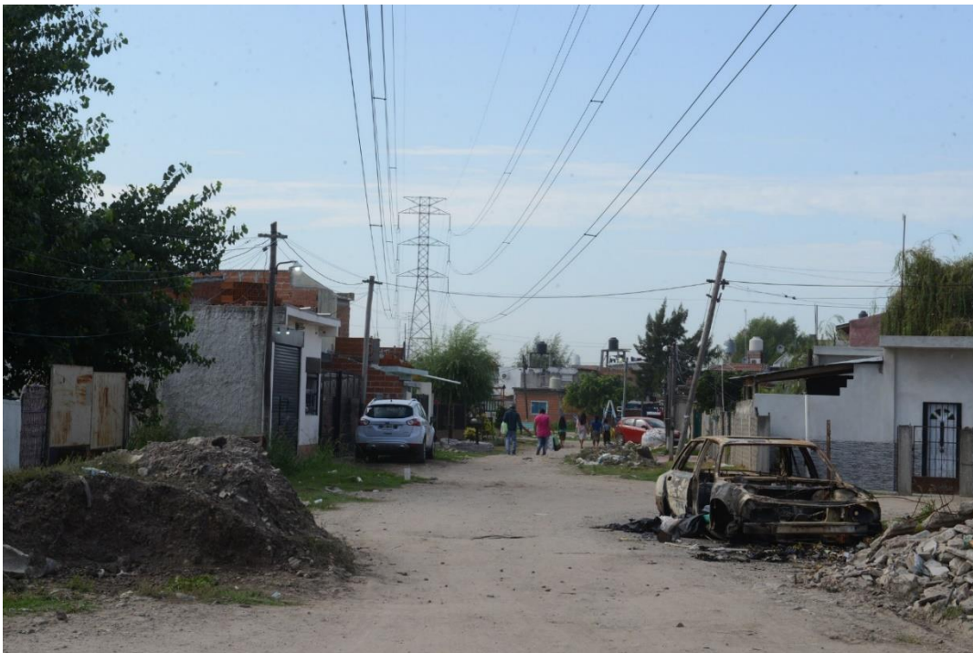
Imagen 14 Presencia de Electroducto – Barrio Costa Esperanza
