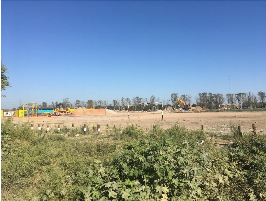
Imagen 17 Zona descampada frente a Costa Esperanza (obras de Camino de Borde)
