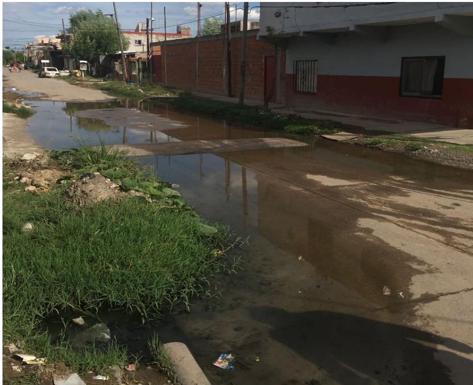
Imagen 16 Anegamientos debido a falta de desagües pluviales adecuados – Barrio Costa Esperanza
