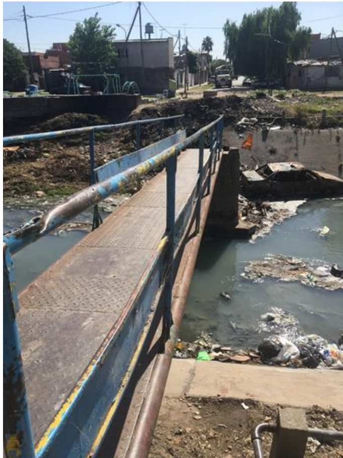
Imagen 4 Puente cortado sobre Canal Jose Ingenieros (restos de autos abandonados y residuos)
