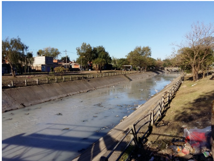
Imagen 7 Canal José Ingenieros (sector revestido por hormigón) oleosidad en el agua y montículos de basura. Fuente visita de campo EIAS Programa
