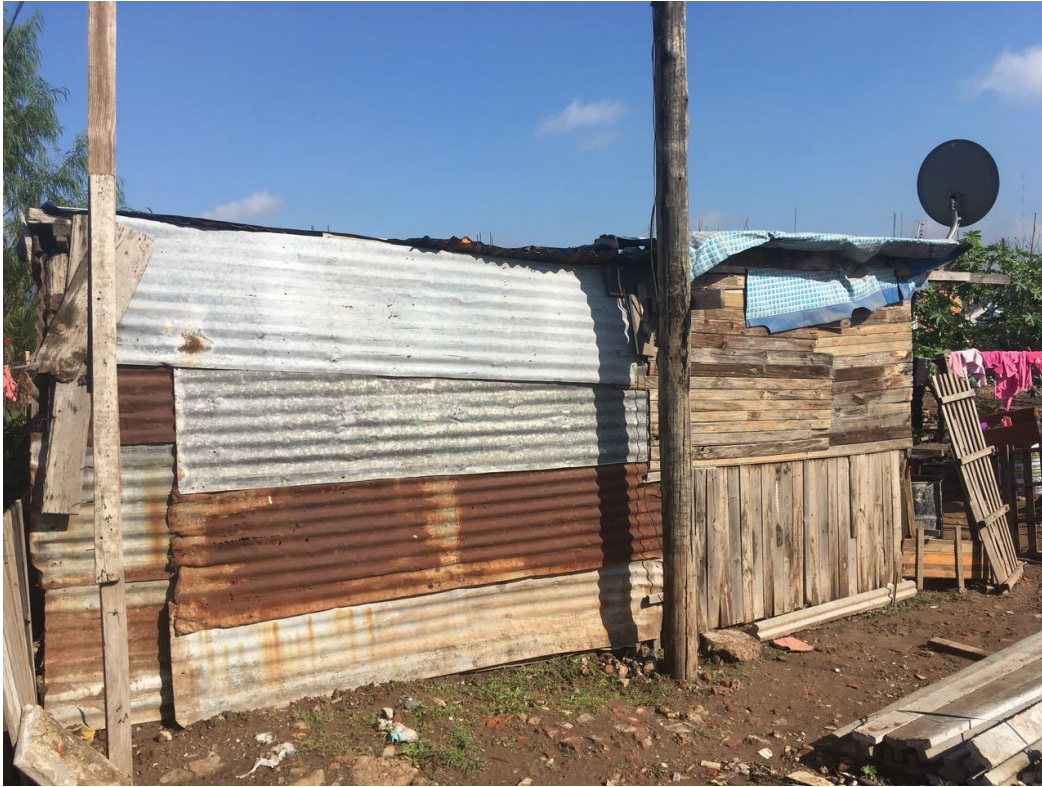
Imagen 9 Viviendas en Barrio 8 de Mayo
