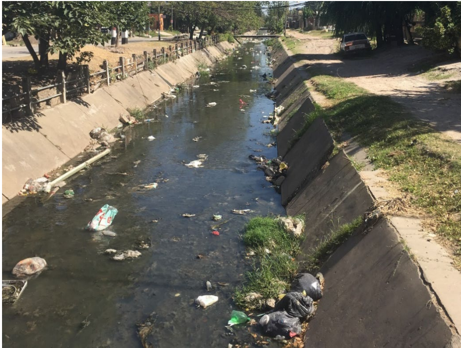
Imagen 9 Residuos arrojados al canal Güemes
